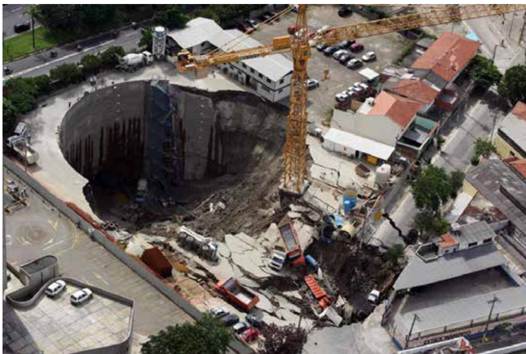
Em construção, obras da estação Pinheiros tiveram de ser paralisadas após abertura de uma cratera
