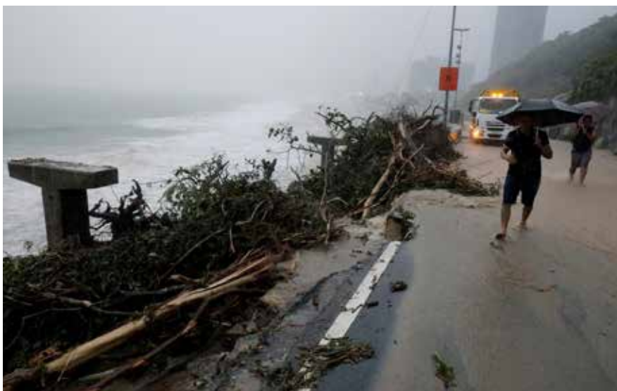
Pela quarta vez, um trecho da Ciclovia Tim Maia desaba em decorrência dos temporais
