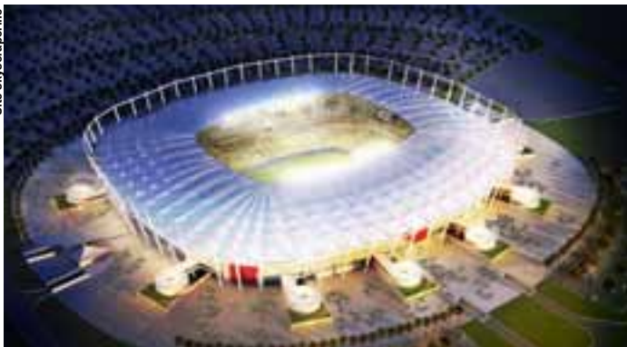
Mané Garrincha, em Brasília: começa a construção da arquibancada superior
